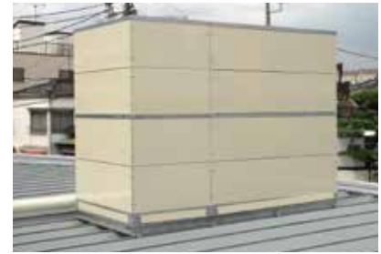
店舗折半屋根設置
