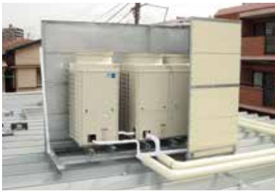
店舗折半屋根設置
